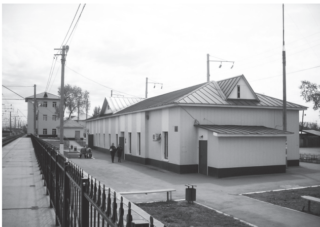
Железнодорожный вокзал станции Анисовка
